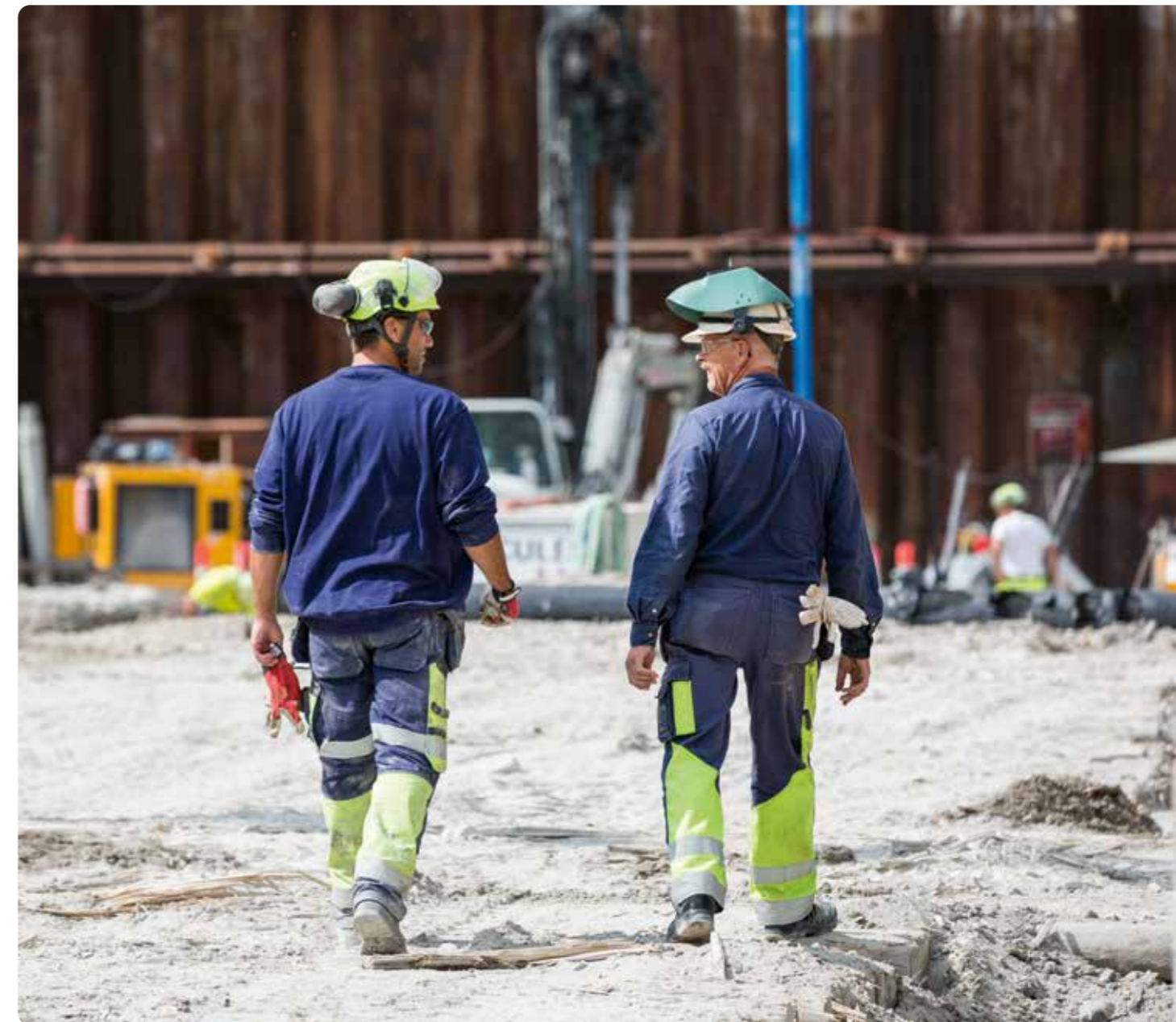
Udførelse af de underjordiske parkeringskældre på PensionDanmarks byggeri Kronløbsøen
